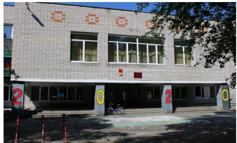
Фото до капитального ремонта
