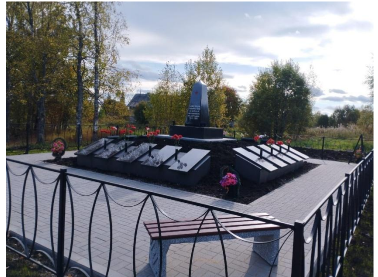
Фото после восстановительных работ
