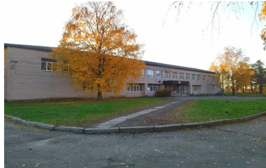
Фото до капитального ремонта
