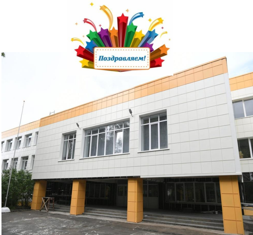
Фото после капитального ремонта
